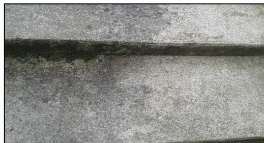
Zone non traitée Zone traitée 5 ans après l'application du NETBIO
